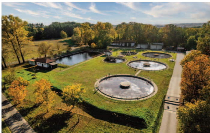
Das moderne, erweiterte Klärwerk der Stadtwerke Bad Belzig.
