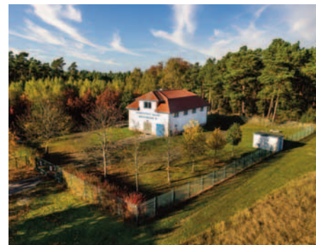
Auf ihre Trinkwasserqualität vertrauen die Bad Belziger zu Recht – Wasserwerk II der Stadtwerke.
